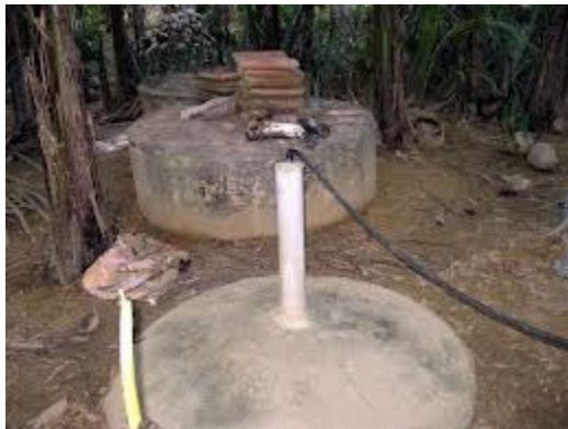
Xây hệ thống biogas
